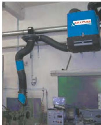
ASPIRAZIONE FUMI DI SALDATURA
